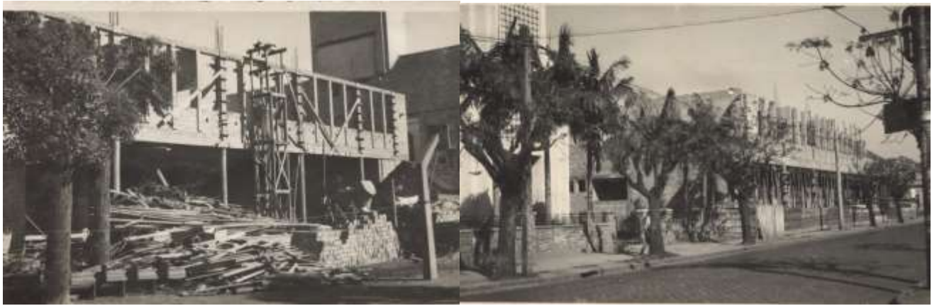
Prédio em construção
