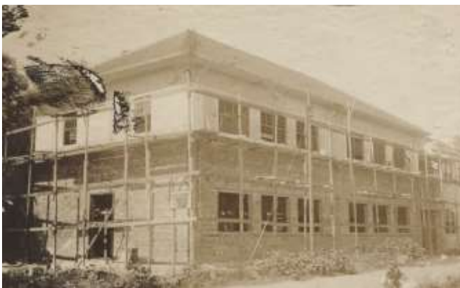
Prédio da Maranhão em construção.
